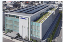
屋上に設置された太陽光発電設備
