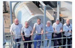
蓄熱式脱臭炉 (RTO)
