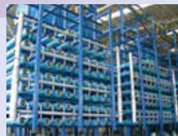
海水淡水化スパイラル型RO膜
