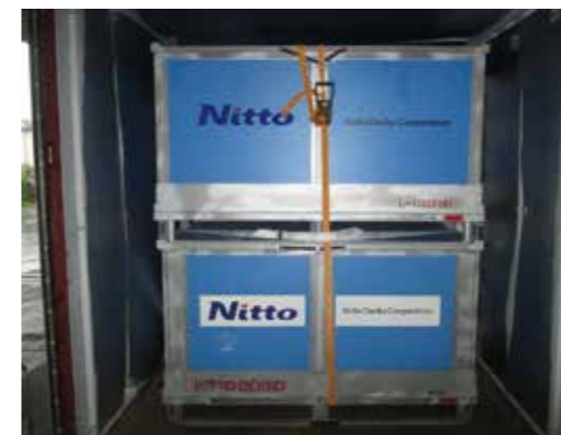
断熱材施工後のコンテナ内部
