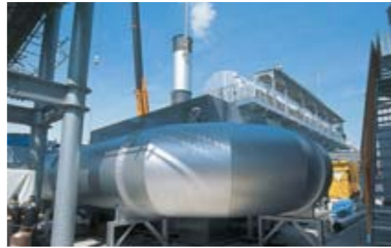
尾道事業所で建設中の新脱臭炉
