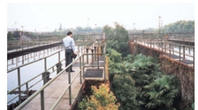
上海の工業団地の排水処理施設
